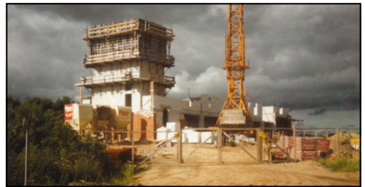
Ein Bild aus der Bauphase ...
