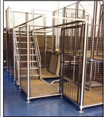
Die Atemschutzübungsstrecke wurde mit einem neuen Fußboden versehen, da der alte Belag sich im Laufe der Jahre auflöste. Der dazu erforderliche Abbau der Atemschutzübungsanlage wurde genutzt, die Anlage komplett zu überholen. Sämtliche Gitter wurden überprüft und erforderlichenfalls instandgesetzt. Die Elektronik wurde ebenfalls geprüft und die Bodenkontakte erneuert. Die Streckenführung indes wurde beibehalten. Die Strecke erstrahlt jetzt in neuem Glanz.
